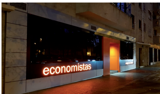
Fachada de la nueva sede del Colegio de Economistas de Sevilla.
